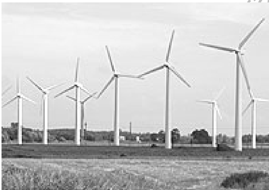
Рис. 3. Ветроэлектростанция в Калининградской области
