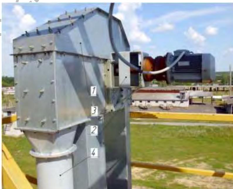
1 – голова нории, 2 – мотор-редуктор, 3 – рама привода, 4 – разгрузочный патрубок
