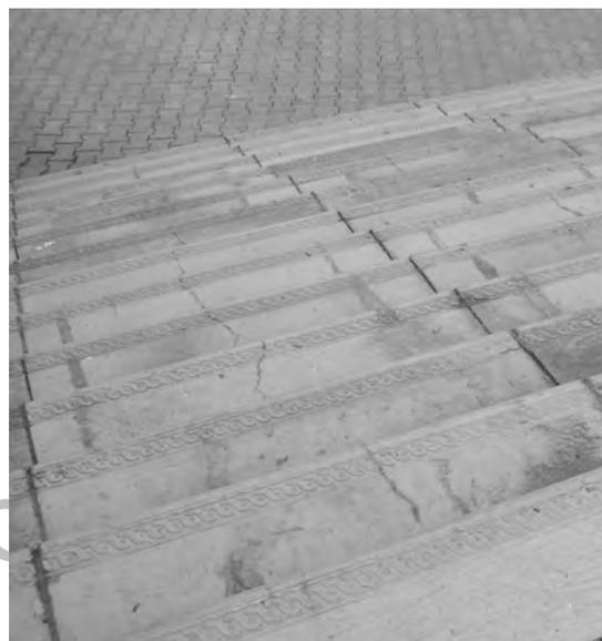
Рис. 2. Повреждения накладных проступей железобетонных лестниц стадиона «Динамо»
