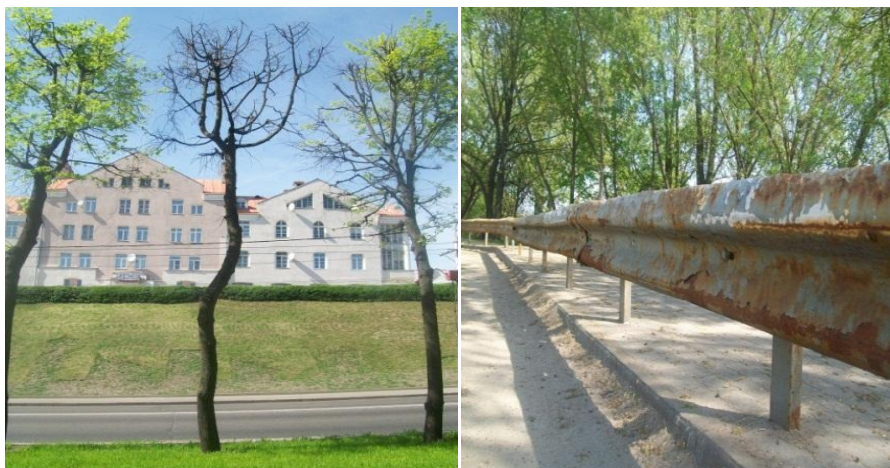
Рис. 1. Поврежденное дерево Рис. 2. Барьерное ограждение
