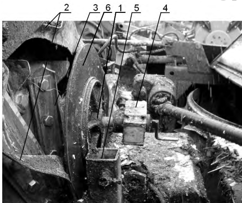
Рис. 7. Вид устройства заточного после аварии
