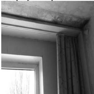
Рисунок 2. Промерзание стыка наружных стеновых панелей
