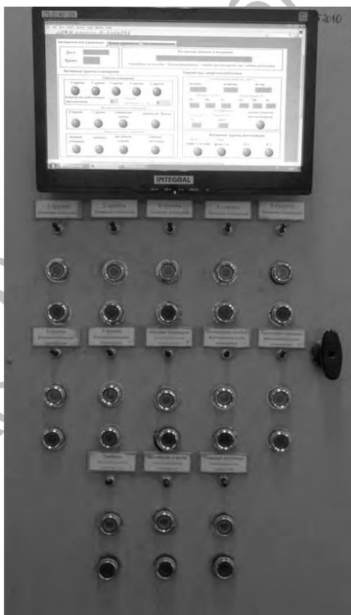
Рис. 3. Пульт управления освещением ледовой арены
