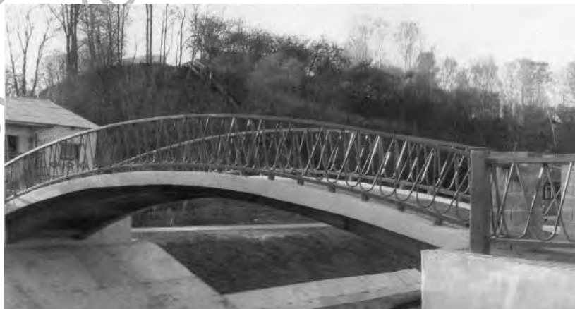
Рис. 3. Мост через реку Дубровенка в г. Могилеве
