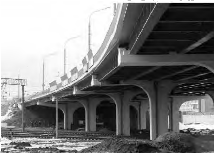
Рис. 4. Фрагмент мостового полотна: а – общий вид; б – путепровод над железнодорожными путями ст. Минск-Северный
