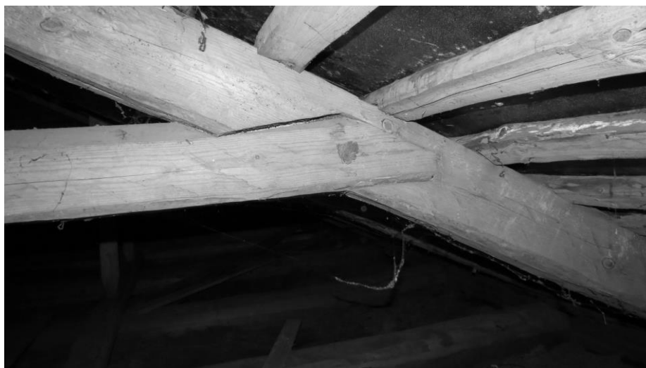
Рисунок 4. – Крепление затяжки к стропильной ноге
