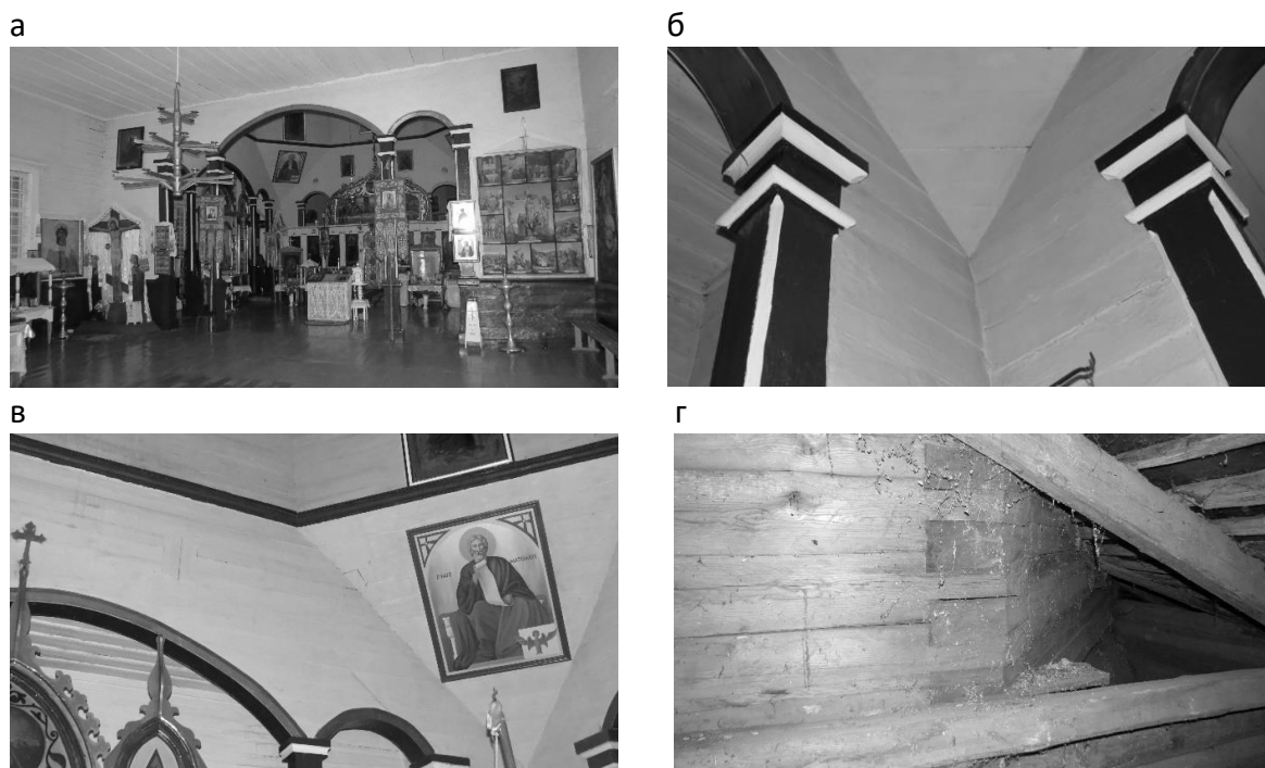
а – арочные проемы в алтарной части; б – имитация капителей в завершении столбов; в – переход прямоугольного сруба основания в восьмигранный барабан (вид изнутри); г – переход прямоугольного сруба основания в восьмигранный барабан (вид со стороны стропильной системы бабинца)
