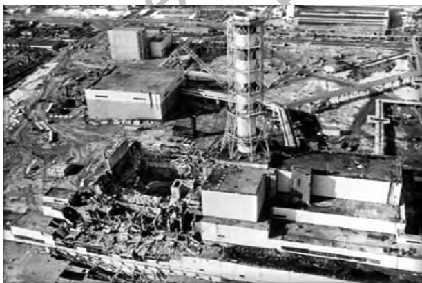
Рис. 6. Вид разрушенного 4-го блока ЧАЭС [9]
