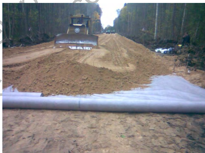
Рис. 1. Строительство опытного участка в Быховском лесхозе
