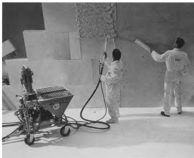
Рис. 4. Нанесение и разравнивание гипсовой шпатлевки на поверхности перегородки из газосиликатных блоков
