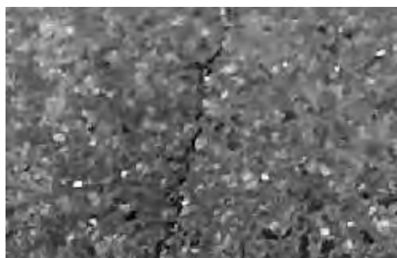
Рис. 9. Термограмма (а) и фотография (б) трещины шириной раскрытия 8 мм
