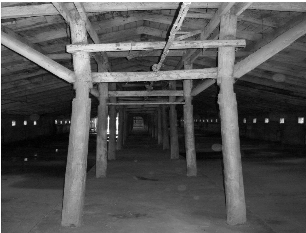
Рисунок 2 – Потеря устойчивости стоек в плоскости поперечных рам
