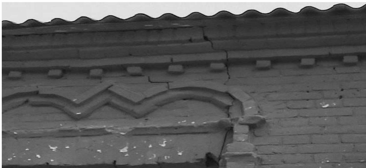
Рисунок 1 – Трещина в стене
