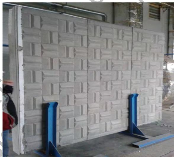
Рис. 2. Декоративная стеновая панель
