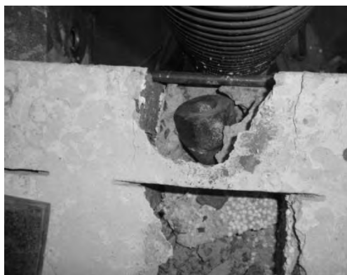
Рис. 2. Характер и схема разрушения полки типа I
