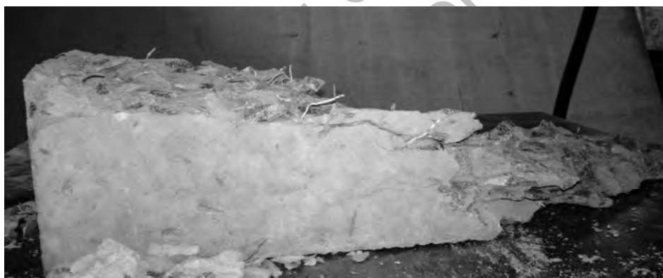
Рис. 6. Призма с фибровым армированием после разрушения с характерным расположением фибр в теле бетона
