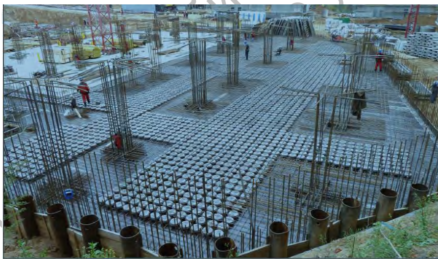
Рис. 1. Применение пустообразователей фирмы «Собіах» в фундаментах
