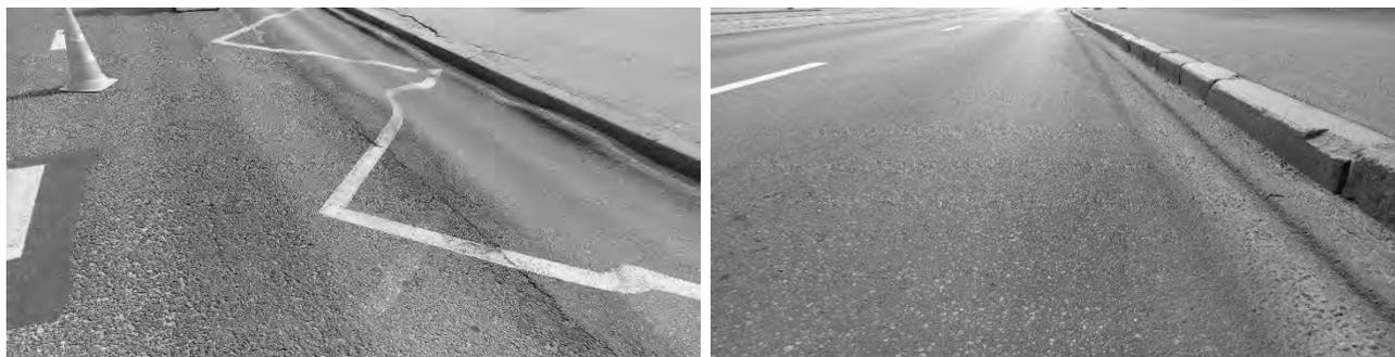
Рис. 1. Образование колеи на остановочных пунктах
