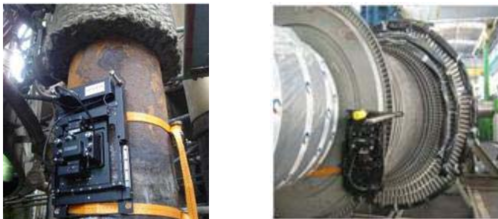
Рис. 12. Труба нефтеперерабатывающей станции и ротор турбины
