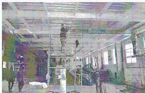
а – усиление настила перекрытия над первым этажом в осях 5-11; б – устройство нового перекрытия в осях 5-11
