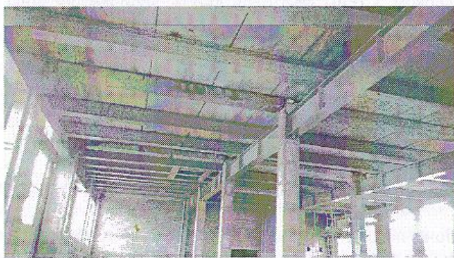
а – усиление настила перекрытия над первым этажом в осях 5-11; б – устройство нового перекрытия в осях 5-11
