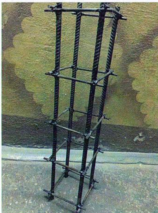
Рисунок 3. – Арматурный каркас для измерения стесненной усадки
