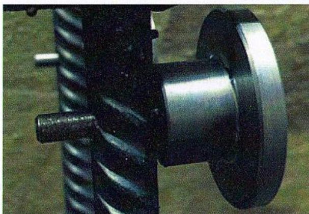
Рисунок 5. – Стальной переходной штуцер в продольной арматуре
