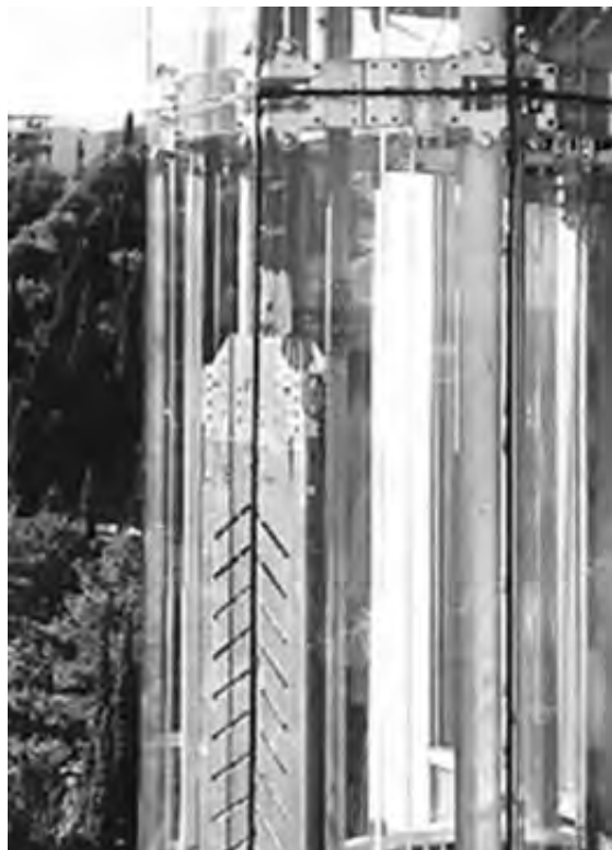
Рис. 6. Панорамный лифт большой грузоподъемности с противовесом кабины фирмы «М-Систем», грузы которого закрыты декоративными стальными щитами
