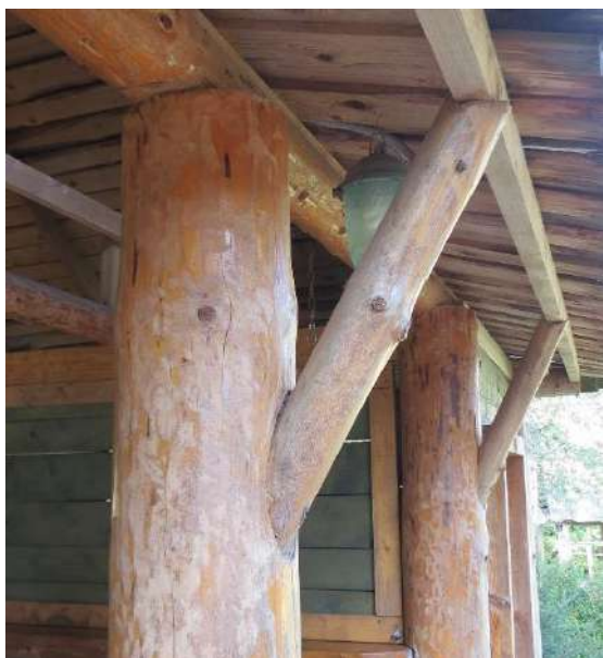
Рисунок 1 – Узел подкоса деревянной цельной стойки
