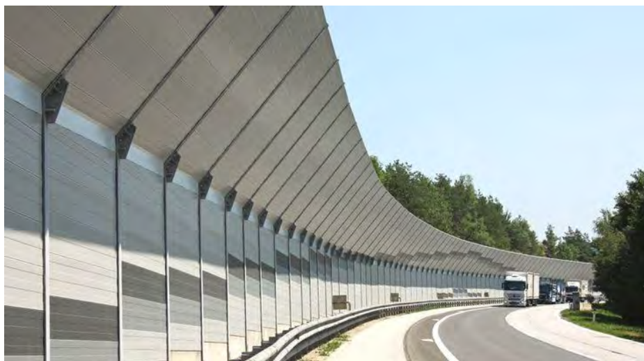
Рис. 4. Звукопоглощающие шумозащитные экраны.
