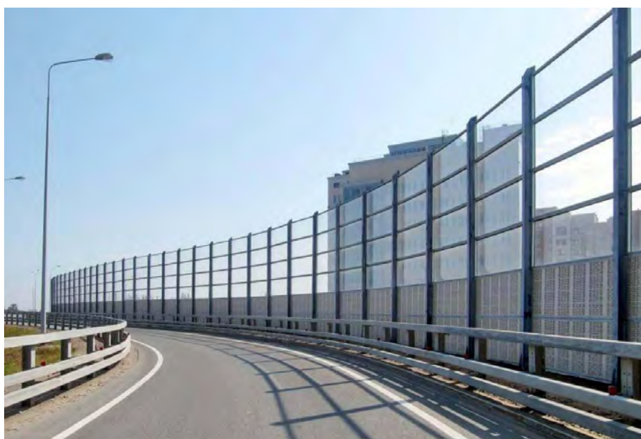
Рис.6. Комбинированные шумозащитные экраны
