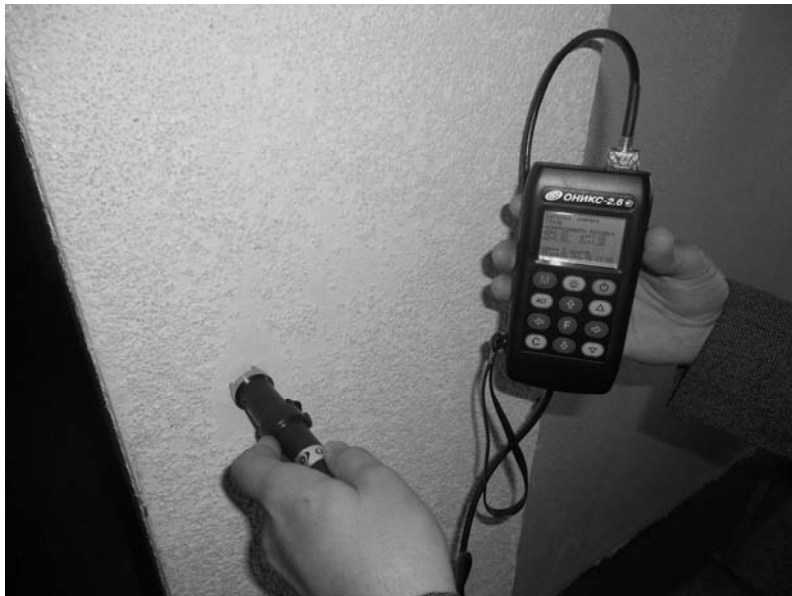
Рисунок 2.3 – Определение прочности бетона на осевое сжатие с помощью ударно-импульсного измерителя ОНИКС-2.6
