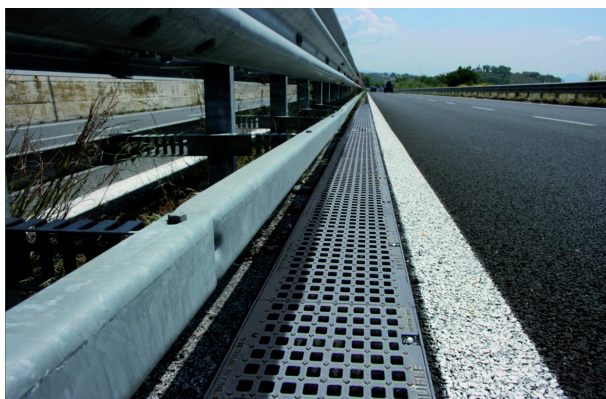
Рис. 2. Пример продольного дренажа
