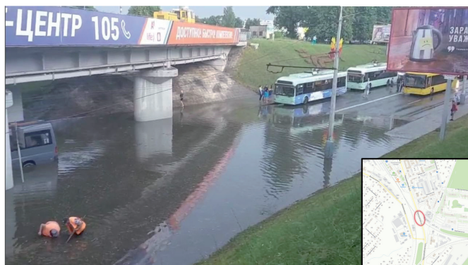
Рис. 1. Затопление на улице Первомайская
