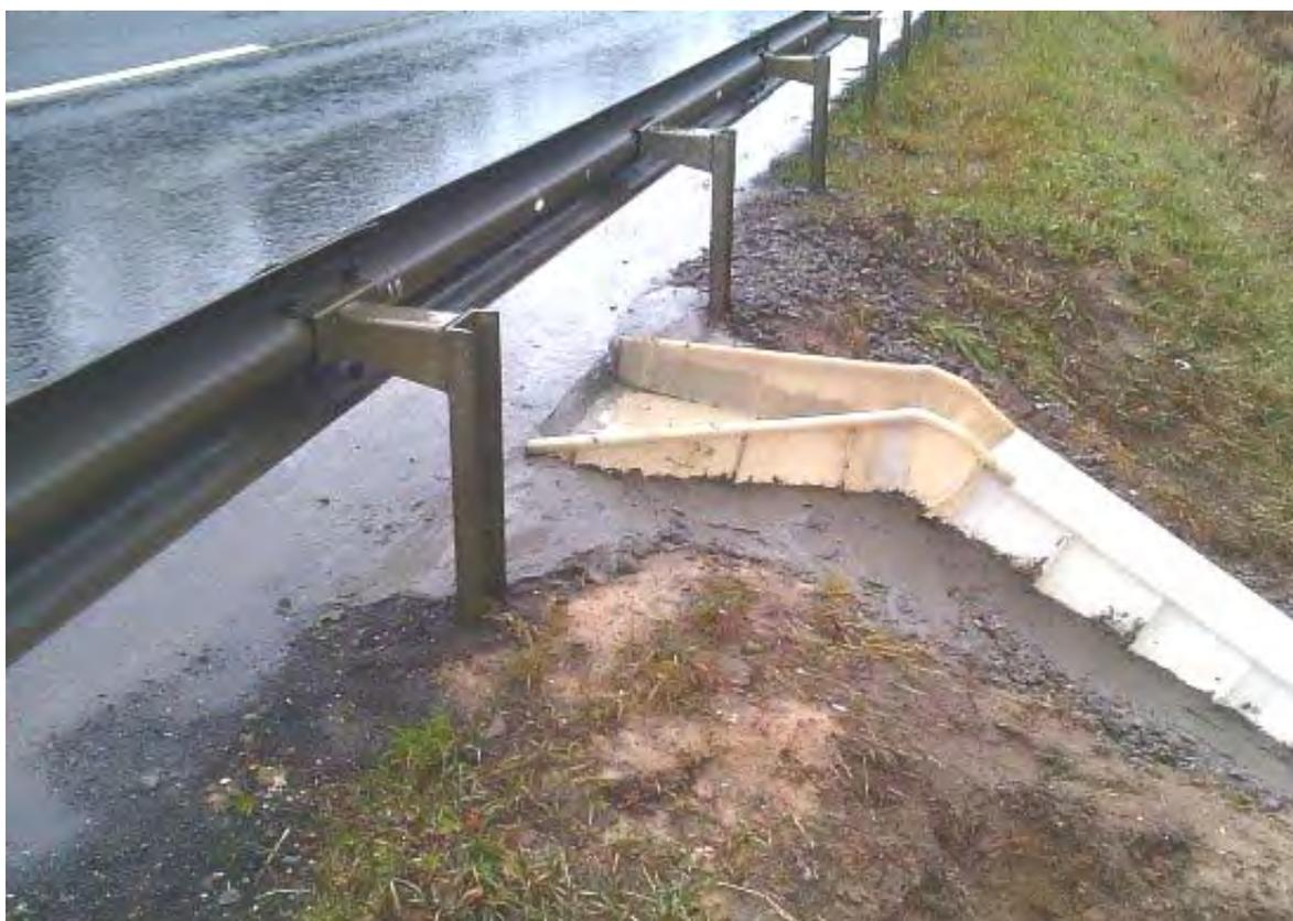
Рис. 1. Стеклопластиковый лоток для отвода воды
