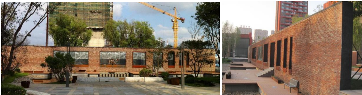
Рис. 2. Виды на отдельно стоящую стену, выполненную методом кладки с поворотом кирпичей
