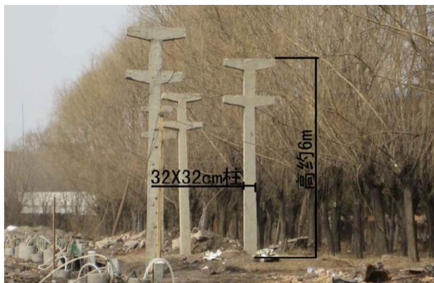
Рис. 13. Вид на бетонные опоры трубопровода перед реновацией
