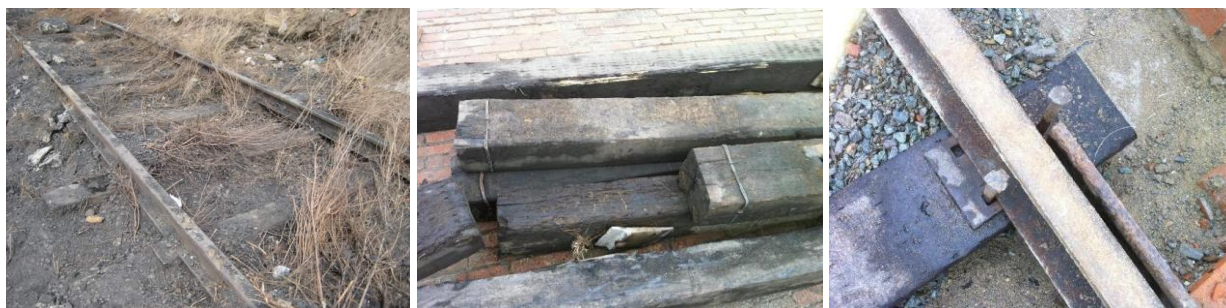
Рис. 9. Железнодорожные пути, шпалы и детали крепления к началу реновации
