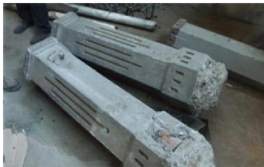
Рис. 18. Бетонные столбы, снятые с главной лестницы офисного здания
