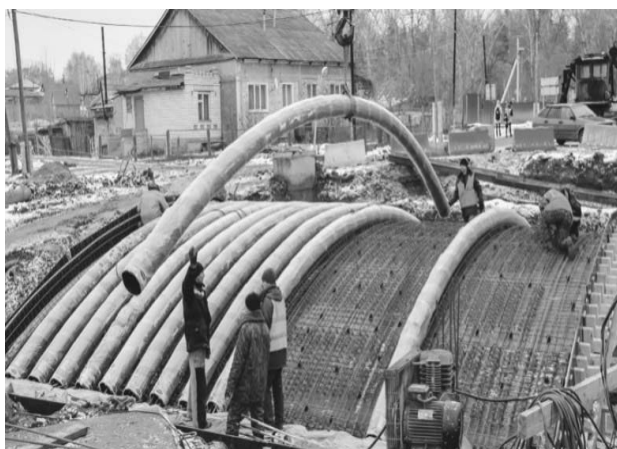
Рис. 1. Строительство моста из углепластика в Ульяновской области
