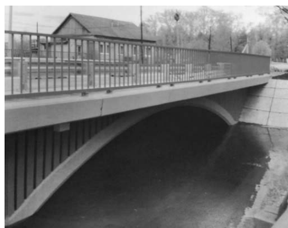
Рис. 2. Внешний вид завершеного мостового сооружения
