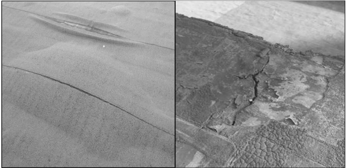
Рисунок 1.2 – Вздутие, непрочное приклеивание, трещины и разрывы рулонного гидроизоляционного ковра
