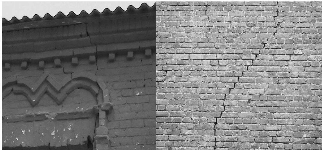
Рисунок 1.1 – Трещина в стене
