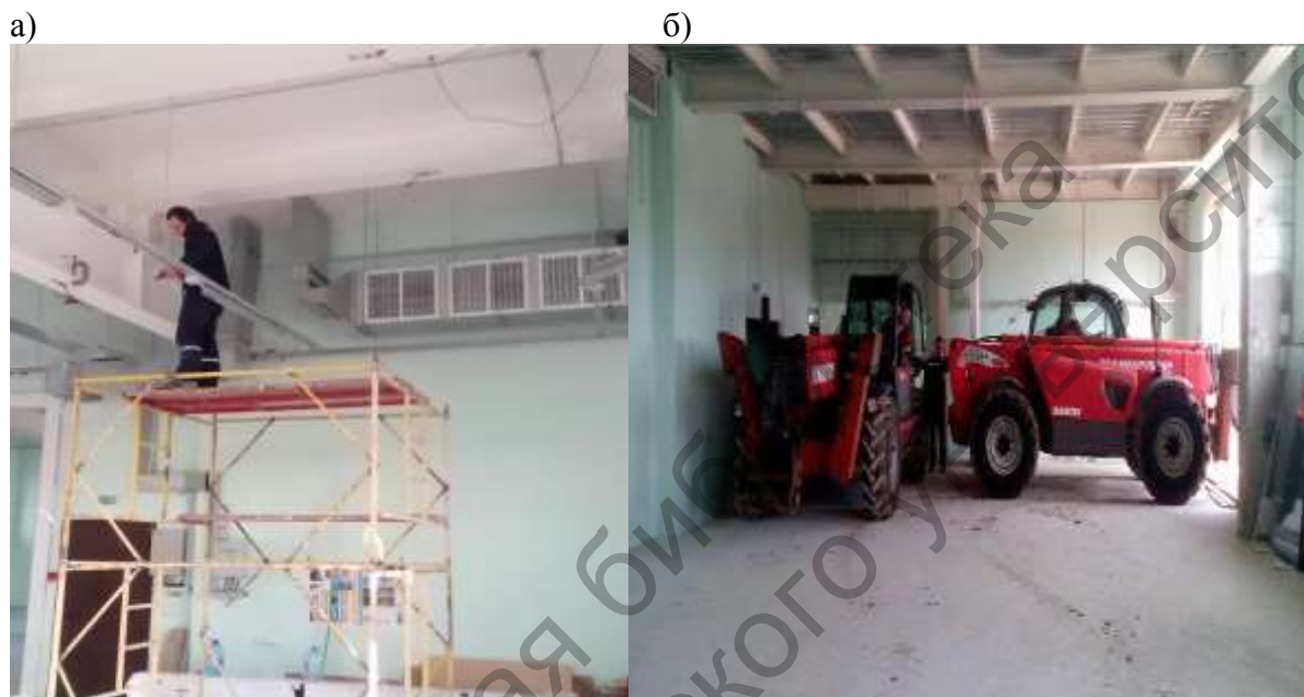
Рис. 1. Опытное нагружение перекрытия в здании: а – установка тензодатчиков и прогибомеров на несущие балки и плиты перекрытия над 1-м этажом; б – загрузение перекрытия статической нагрузкой
