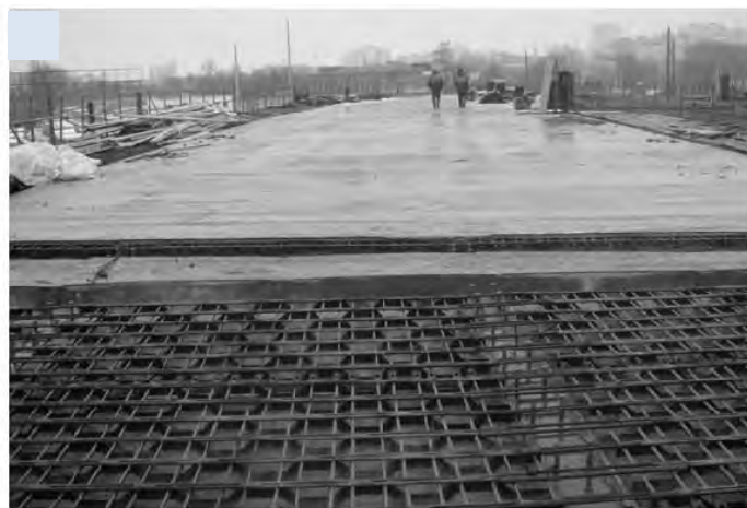
а – металлические составляющие КНЭСК на монтажной площадке; б – проезжая часть путепровода на этапе бетонирования
