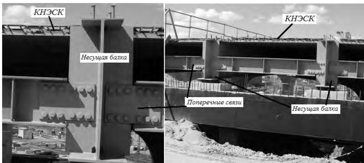
Рисунок 2.51 – Металлическая составляющая КНЭСК при монтаже путепровода Минск-Северный
