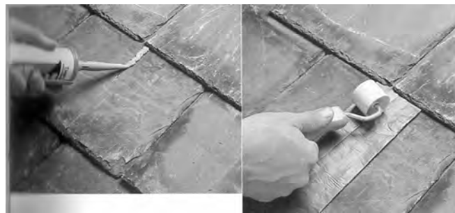
Рисунок 7 – Починка треснувшей плитки
