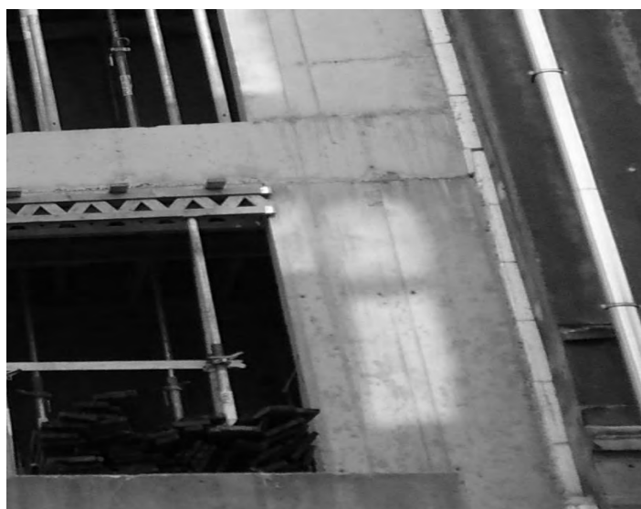
Рис. 1. Плиты беспрессового пенополистирола, уложенные между стенами зданий
