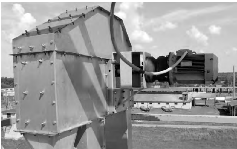
Рисунок 3.30 – Испытания мотор-редуктора в составе привода нории
