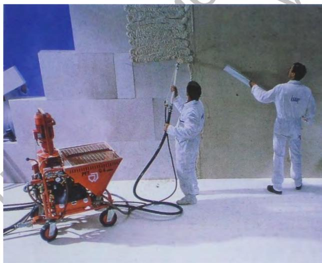
Рис. 1. Механизированное оштукатуривание стен
