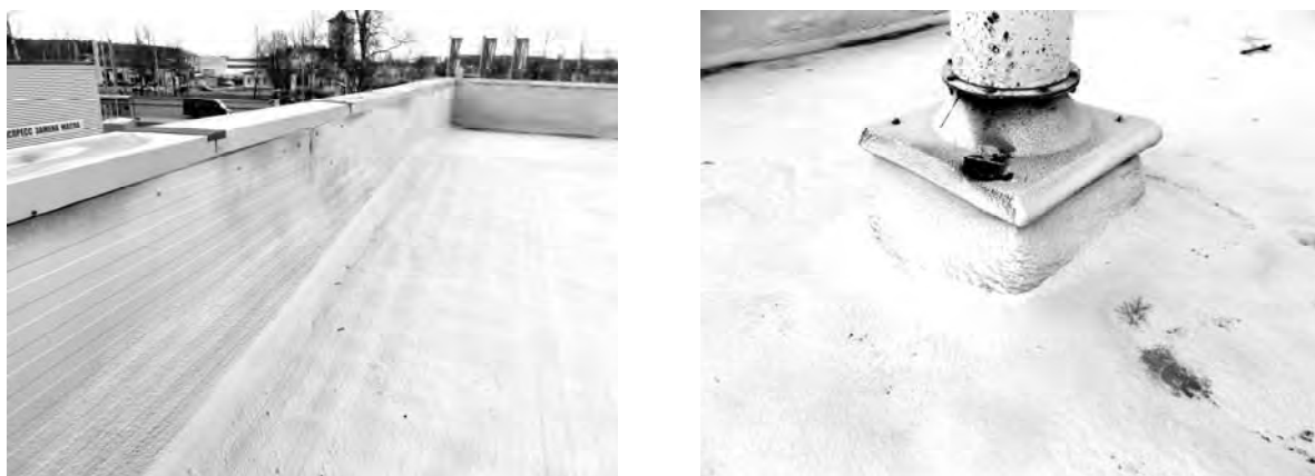
Рис. 2. Вид на элементы кровли с покрытием из пенополиуретана
