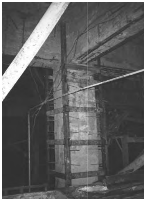
Рис. 5. Усиление железобетонной колонны стальной обоймой с обетонированием: а – верхняя часть стальной обоймы усиления; б – нижняя часть стальной обоймы усиления
