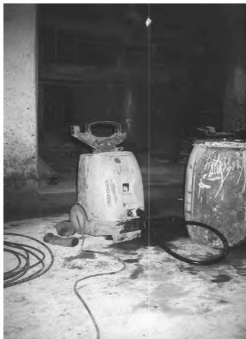
Рис. 4. Подготовка поверхности бетона и очистка арматуры гидромонитором KARCHER: а – гидромонитор KARCHER; б – подготовка поверхности бетона и очистка арматуры
