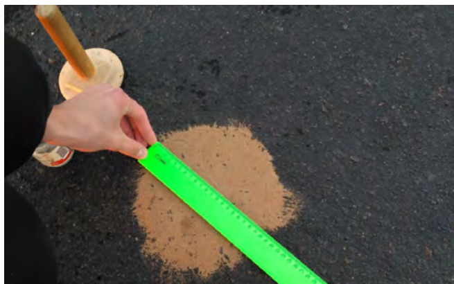
Рис. 3. Контроль сцепных качеств покрытия методом «песчаное пятно»
